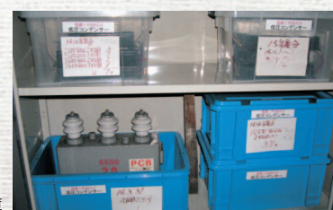
PCBを含むコンデンサ類保管庫
